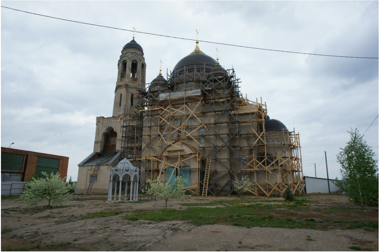
Фото №1. Общий вид южного фасада.
