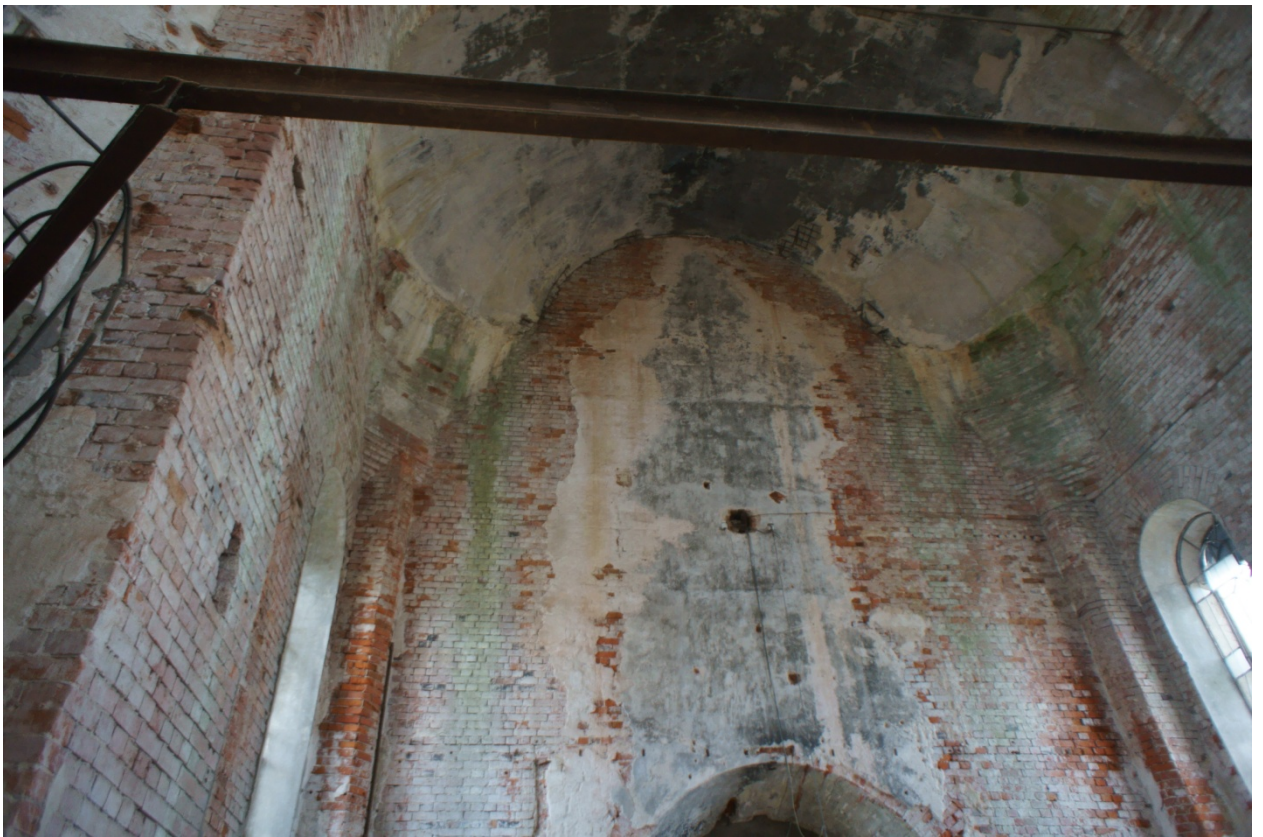
Фото №8 Интерьер основного объема храма (западная часть). Вид на западную стену и сводчатое перекрытие.
