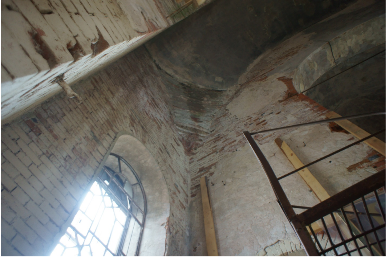
Фото №9.Интерьер основного объема храма (восточная часть, перед апсидами). Опираие железобетонного свода на кирпичные паруса.
