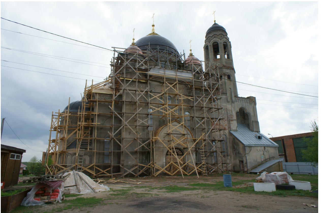
Фото №2. Общий вид северного фасада.
