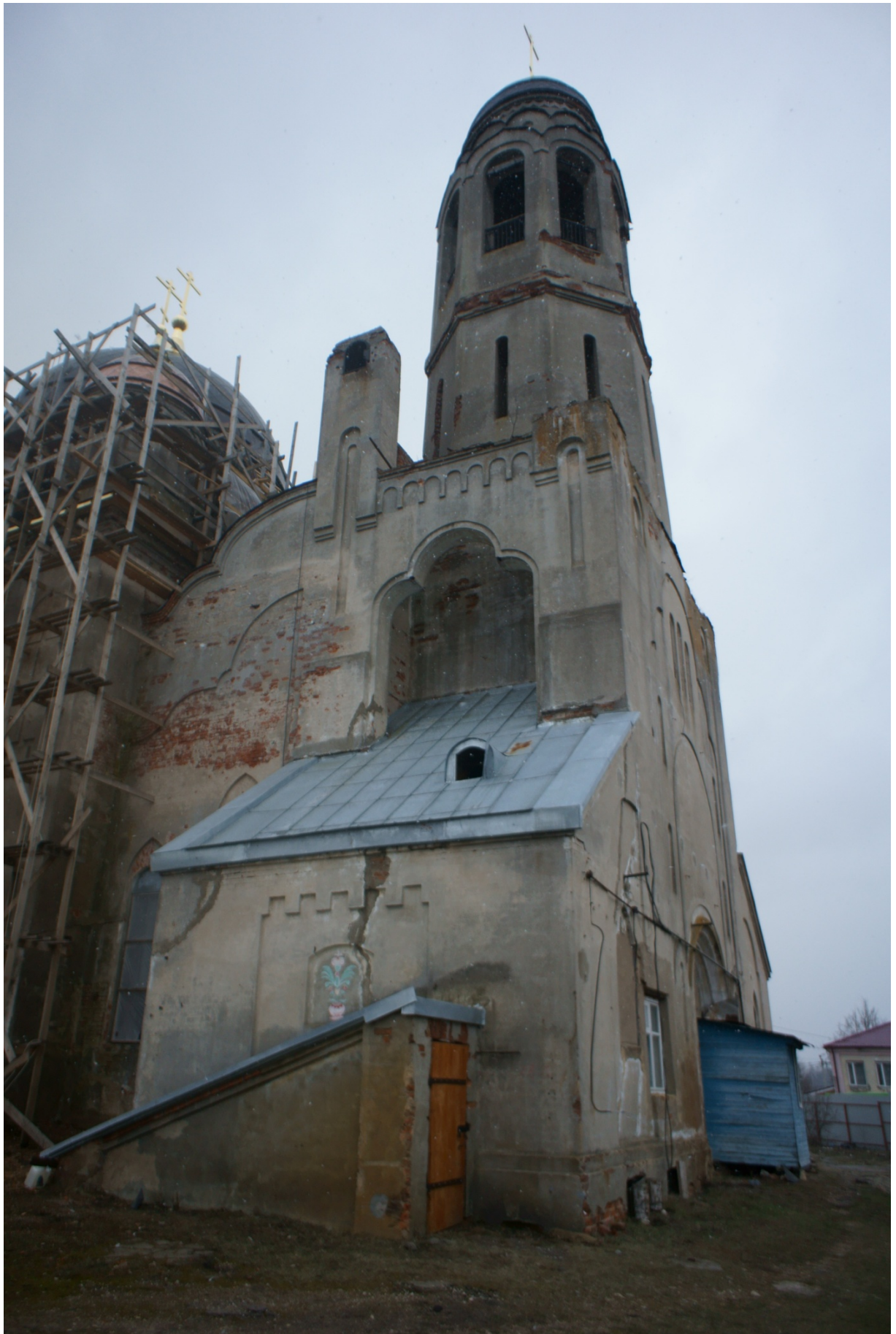
Фото №4. Северный фасад колокольни с лестницей спуска в подвал.
