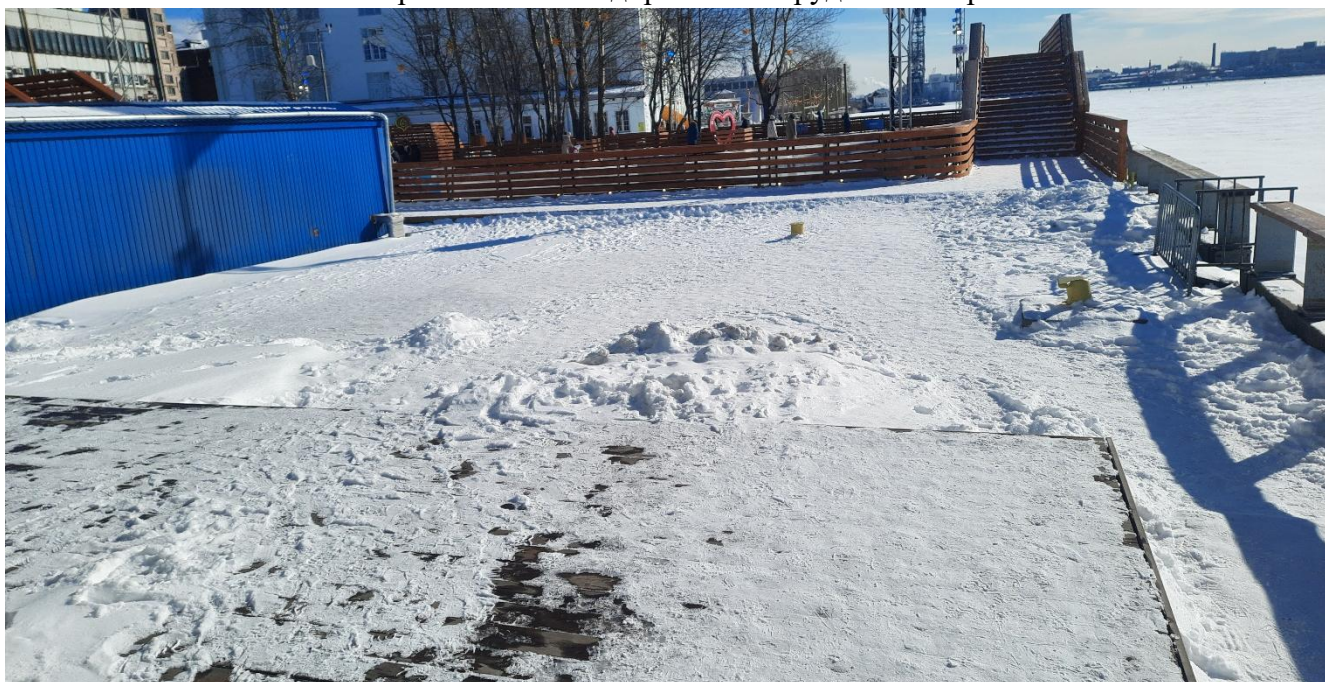
Участок временного складирования нерудных материалов.
